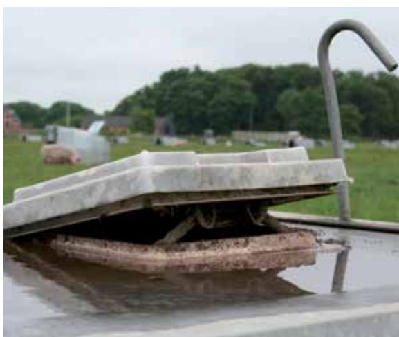
Ventilationsåbningen bruges til at regulere temperaturen og luftskiftet i hytten. Foto: Heidi M. Andersen
